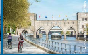
Die Pont des Troux, ein sehenswerter Überrest“ der mittelalterlichen Militärarchitektur
